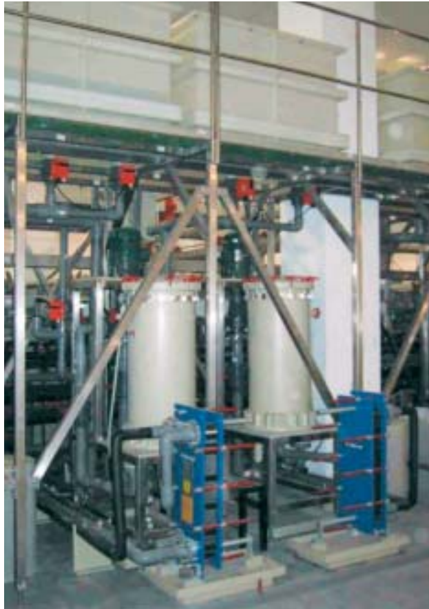
Пластинчатые теплообменники Alfa Laval, установленные на заводе PAL по производству полупроводников в Шенжене рядом с Гонконгом.
