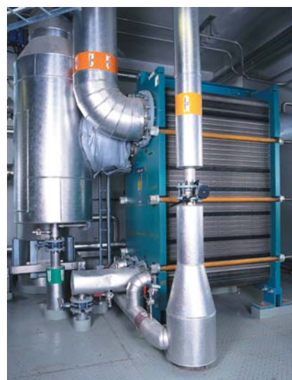
Конденсатор этанола. Компания Absolut (Швеция). Все колонны компании Absolut на дистилляционном заводе в г. Бhus имеют ребойлеры и конденсаторы компании Альфа Лаваль. Аппараты Альфа Лаваль были выбраны в связи с их компактностью.
