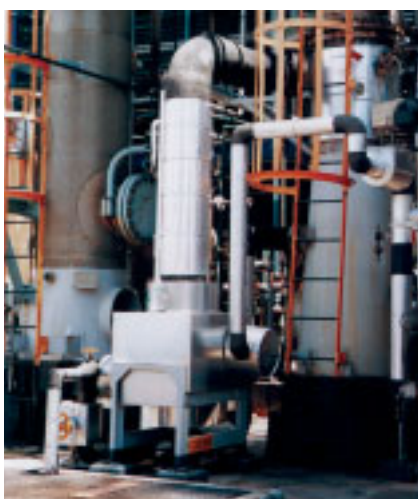
Компаблок как ребойлер десорбционной колонны этилацетата на заводе в Родиа, Бразилия
