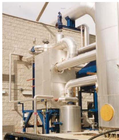
AlfaVar ребойлер, работающий по принципу термосифона, на заводе Carbonесо (Испания)
